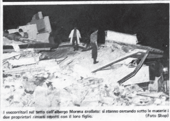
I soccorritori sul tetto dell'albergo Morera crollato: si stanno cercando sotto le macerie i due proprietari rimasti sepolti con il loro figlio. (Foto Shop)
